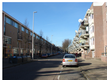
jaren 80 nieuwbouw Nassauhaven
