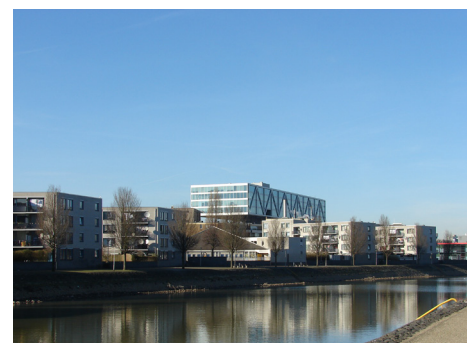
jaren 80 nieuwbouw Nassauhaven
