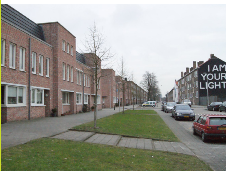
Charloisse tuinen, nieuwbouw
